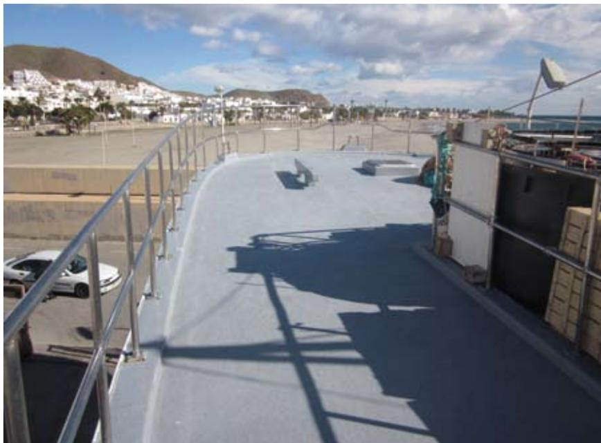
**Ilustración 1.** Protección con barandilla de 1 metro de altura
